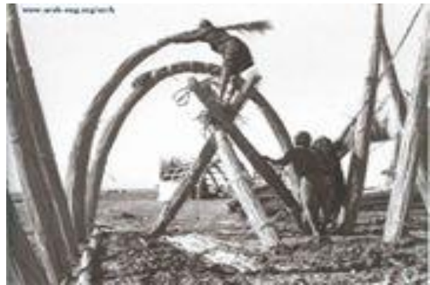
الشكل (10) الأقواس الهيكلية التي تعطي شكل القبة النهائي في مبنى الأهوار التقليدي
