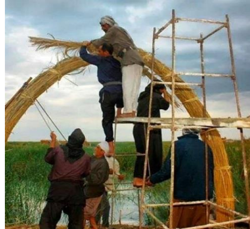
الشكل (9) طريقة إنشاء العناصر الأساسية للهيكل الإنشائي في مبنى الأهوار التقليدي
