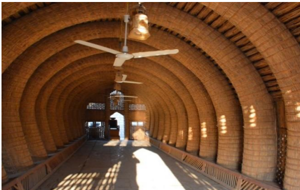
الشكل (13) الاختلاف في سمك القوس الإنشائي تبعاً لأجزائه المعرضة للحمل بصورة مباشرة وغير مباشرة
