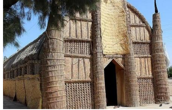
الشكل (11) إعطاء الشكل النهائي للهيكل الإنشائي في مبنى الأهوار التقليدي
