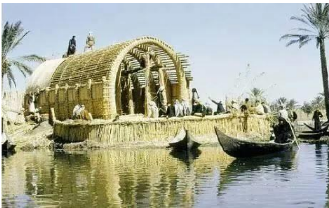
الشكل (10) الأقواس الهيكلية التي تعطي شكل القبة النهائي في مبنى الأهوار التقليدي
